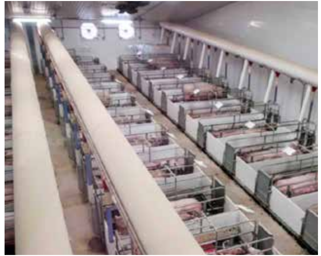
Điều khiển quạt thông gió trang trại sử dụng biến tần GD200A
