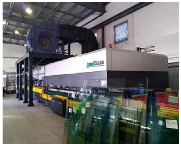
Điều khiển quạt đối lưu cưỡng bức kính cường lực sử dụng biến tần GD200A
