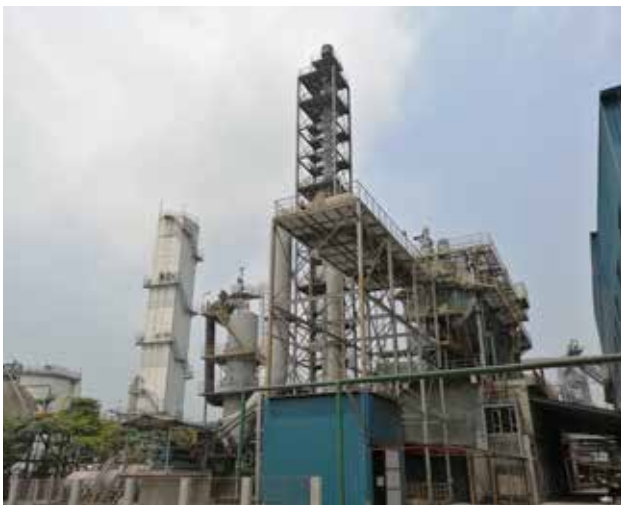
Điều khiển quạt thu hồi Ventury sử dụng biến tần trung thế GD5000
