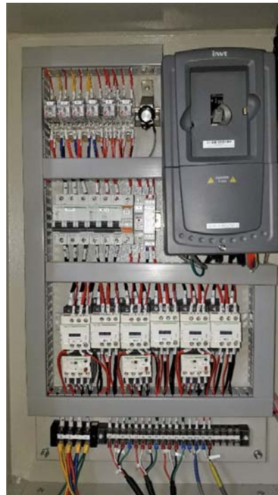
Hình thiết kế tủ bơm nước GD300-16
