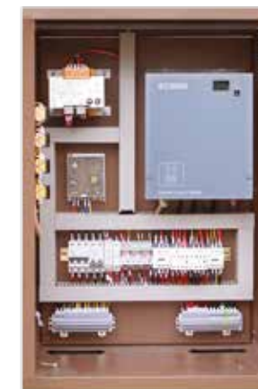
Tủ điều khiển thang máy tích hợp EC3000
